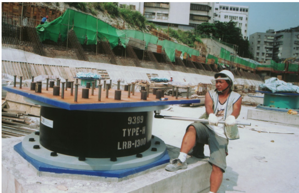
慈濟醫院台北分院工程，正積極進行鋼環阻尼器(蝴蝶形隔震器)基座的建築。攝影／詹新國
